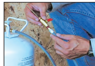
Fixer le boyau et la lance d'application au réservoir.
